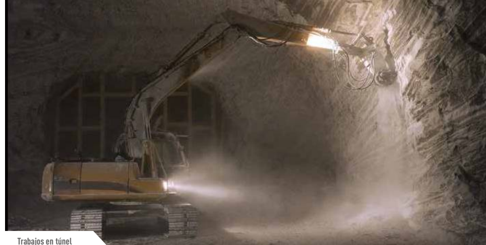
Trabajos en túnel
