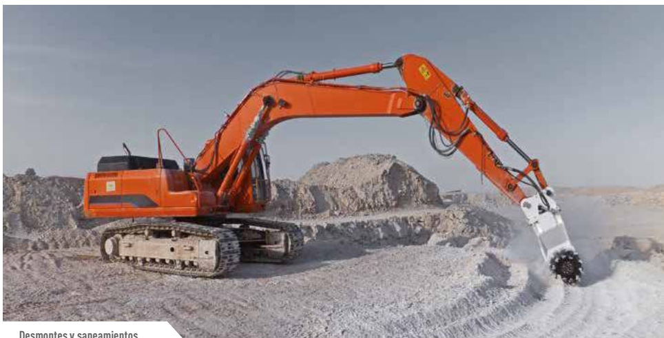
Desmontes y saneamientos
