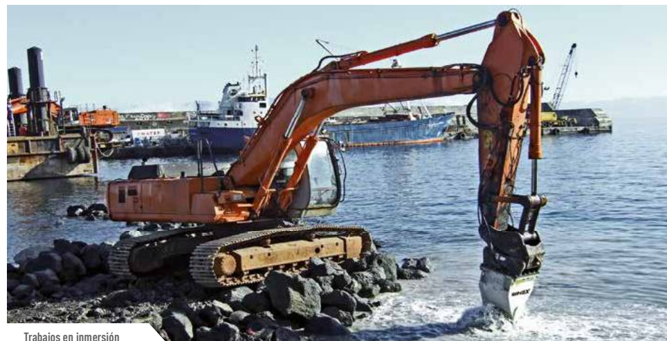
Trabajos en inmersión
