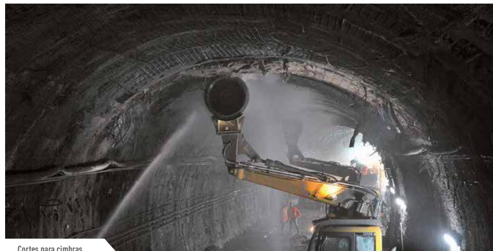
Cortes para cimbras
