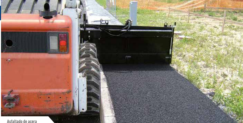
Asfaltado de acera
