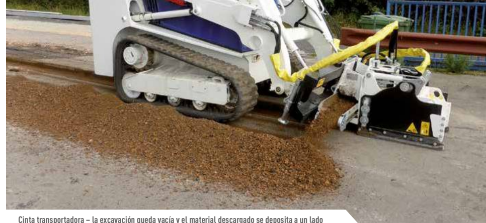
Cinta transportadora – la excavación queda vacía y el material descargado se deposita a un lado
