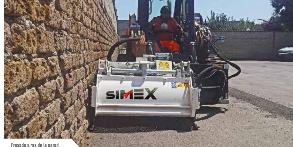
Fresado a ras de la pared
