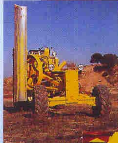
Máximo ángulo de talud de 90°
