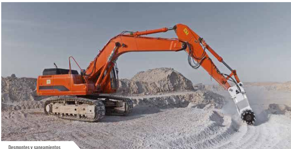
Desmontes y saneamientos
