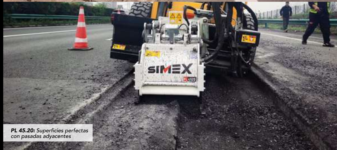
PL 45.20 HP: Reparación de una desestabilización vial.
