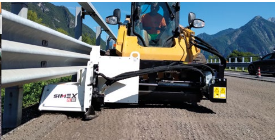
Cinta de PL SG que descarga material fresado lateralmente
