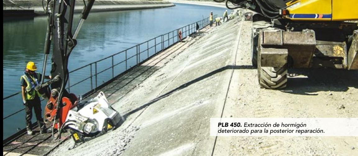
**PLB 450.** Extracción de hormigón deteriorado para la posterior reparación.
