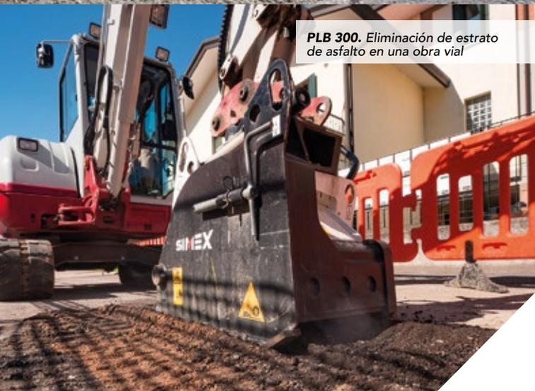
**PLB 300.** Eliminación de estrato de asfalto en una obra vial
