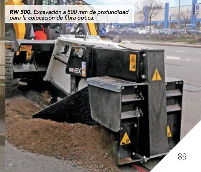
**RW 500.** Excavación a 500 mm de profundidad para la colocación de fibra óptica.
