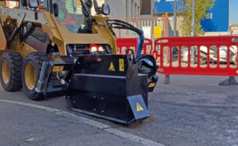
T 300. Realización de mini zanja con disco de 25 mm de ancho.
